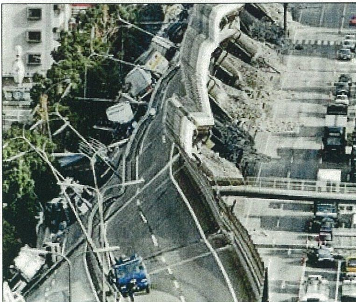
(高速道路 倒壊の様子)
