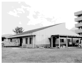
血液浄化センター改修工事着工 = 旧隔離病舎
