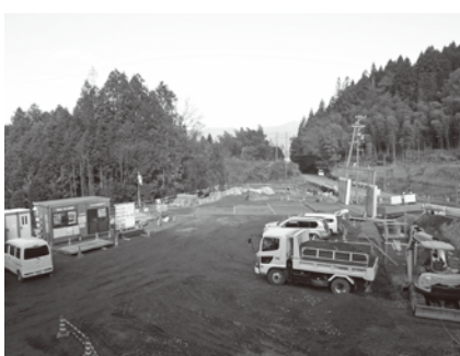
工事ヤード整備の様子
