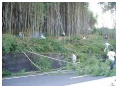
【写真:市民の協力による伐採の様子】
