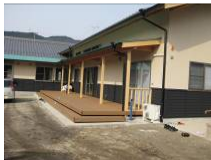
【写真:平成 20 年度に整備されたグループホーム】
