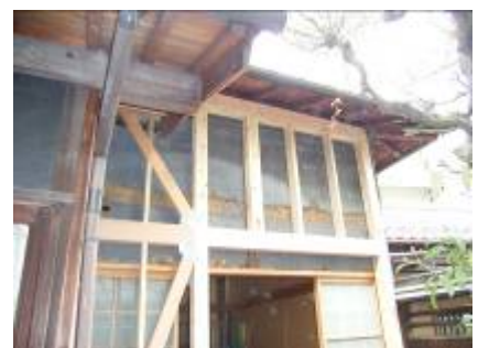
【写真: 耐震補強工事の様子】
