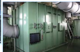
大きな吸引装置で施設内の臭いはすべて吸引し、建物内に設置されている最先端の脱臭設備で無臭化します。
