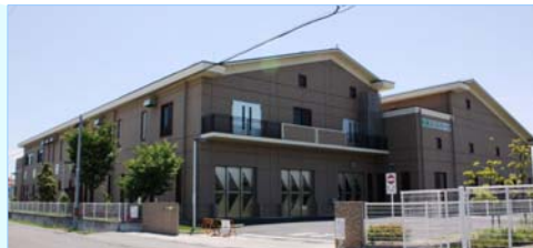
先進施設は、すべての設備を建物で覆う密閉構造で、防臭対策は万全です。
