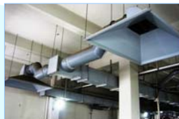
大きな吸引装置で施設内の臭いはすべて吸引し、建物内に設置されている最先端の脱臭設備で無臭化します。
