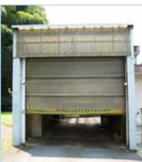
バキュームカーの出入口は、旧式のビニール製の扉が1枚だけ。
