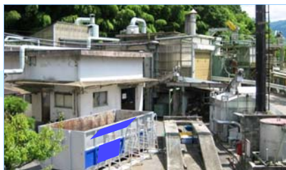
老朽化した中津川衛生センター。処理設備の多くは屋外に露出。
