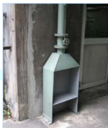
旧式の臭気吸引装置と、屋外に露出した脱臭設備。
