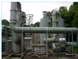
旧式の臭気吸引装置と、屋外に露出した脱臭設備。
