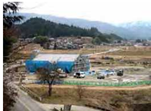
【写真:農業集落排水事業阿木地区処理場(建設中)】
