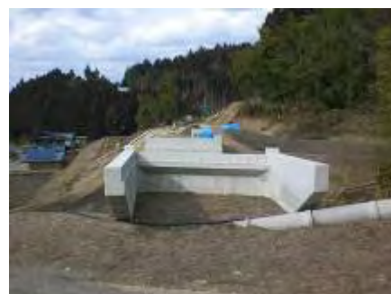
【写真：ふるさと椿街道整備工事の様子】
