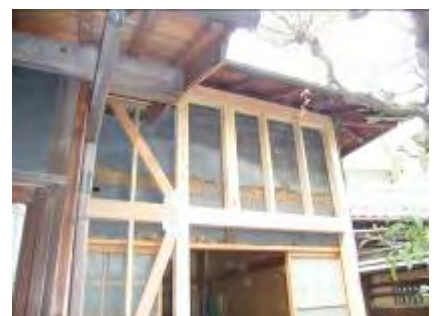
【写真: 耐震補強工事の様子】
