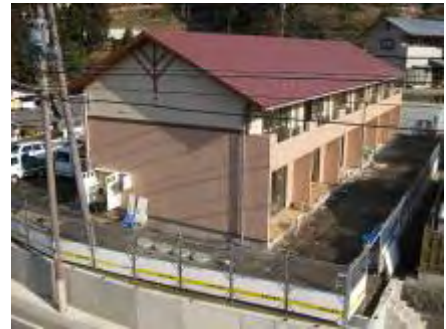
【写真：神坂地域に建設されたUI ターン者用住宅】
