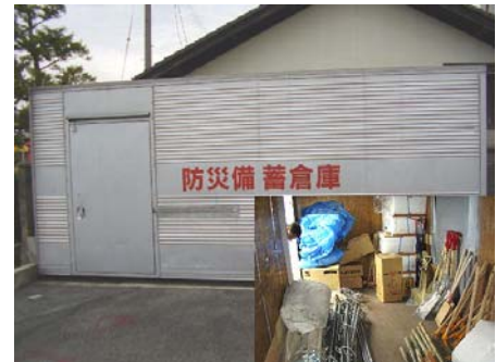
【写真:防災備蓄倉庫の外観と内部】
